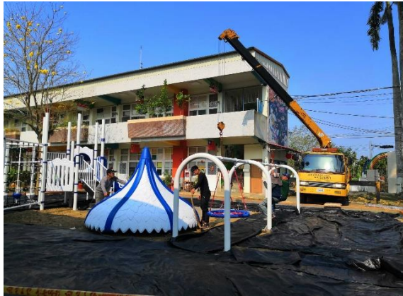
兒童遊戲場施工中
