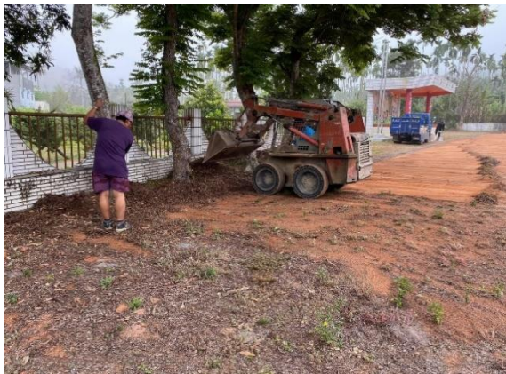
109學年度操場紅土回填施作中
