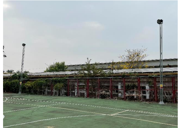
籃球場照明設備改善
