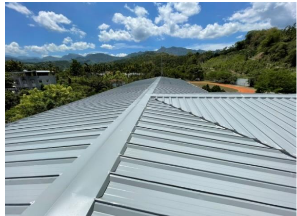
東棟校舍防水隔熱工程施工完成
