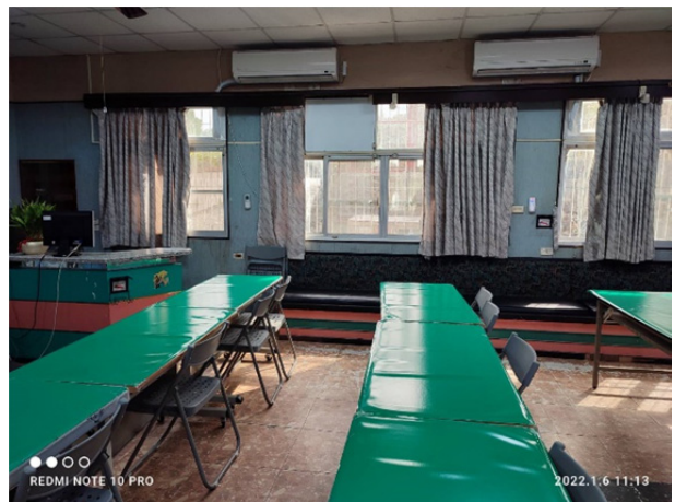
教室安裝冷氣電力工程
